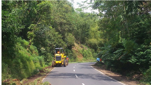
Gambar 9.10. Pemeliharaan bahu jalan dengan alat mekanis
