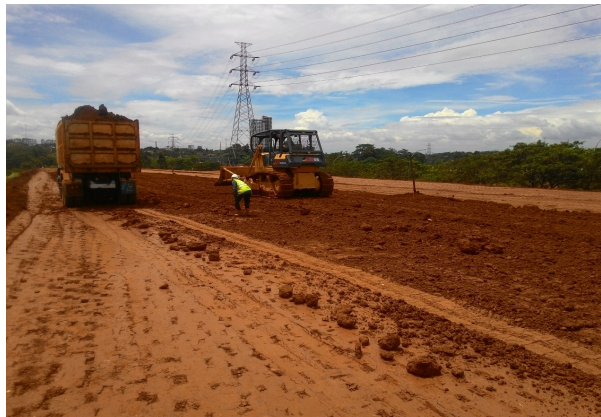
Gambar 9.5. Tahapan persiapan pekerjaan tanah proyek jalan
