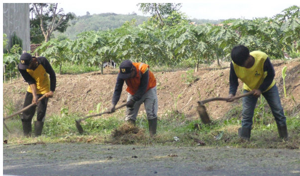
Gambar 9.8. Pemeliharaan bahu jalan secara manual
