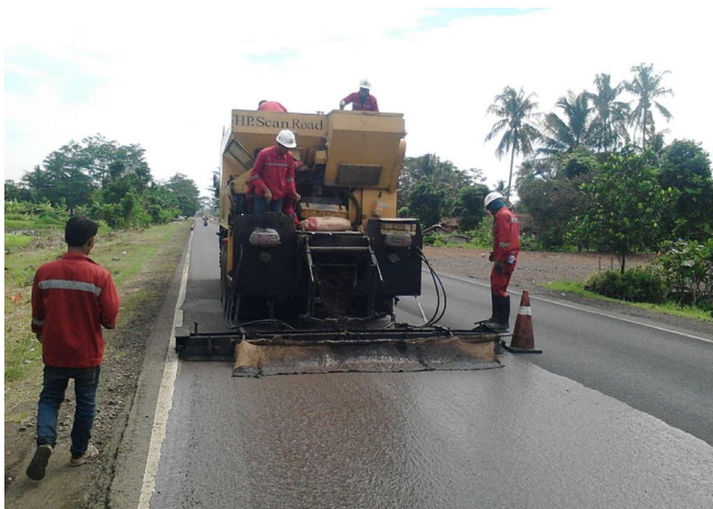
Gambar 9.12. Pekerjaan slurry seal
