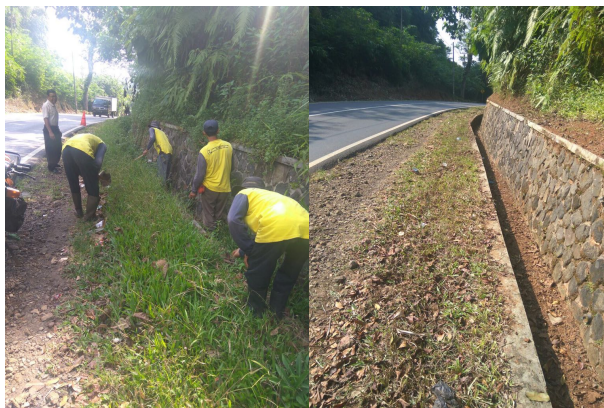
Gambar 9.11. Pemeliharaan saluran secara manual
