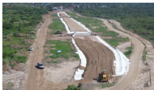
Gambar 4. Pekerjaan di lokasi liquefaksi
