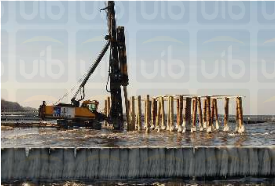
Gambar 2.3 : Tiang Pancang Kayu
