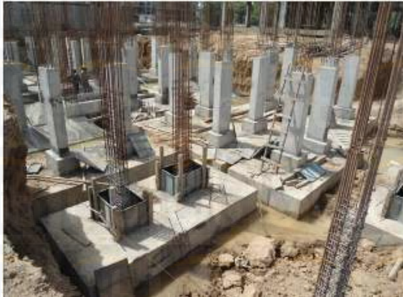
Gambar 2.7 : Pondasi Tapak
