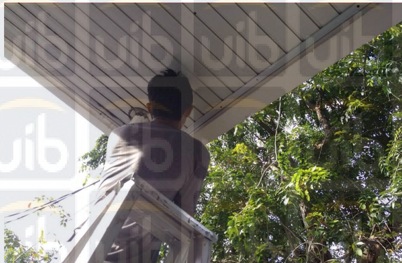
Gambar 3.3 Proses Memasang Kamera CCTV Bagian Outdoor
