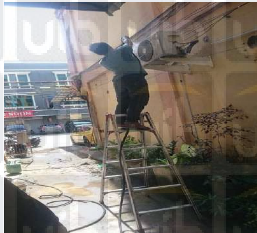
Gambar 3.2 Mencuci bagian Outdoor dari AC ( Air Conditioner )
