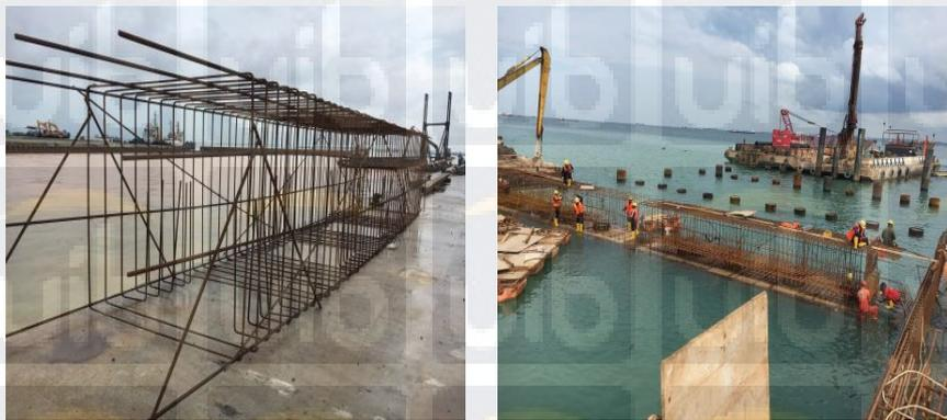
Gambar 4.10 Proses Pembesian *Pile Cap*, sumber:ProyekPembangunan Dermaga Kabil
