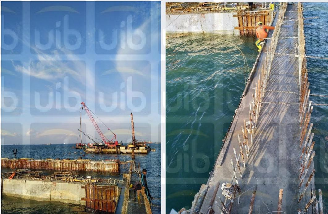
Gambar 4.11 Proses Pengecoran *Pile Cap*, Sumber:Proyek Pembangunan Dermaga Kabil
