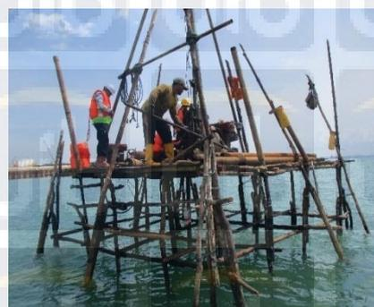
Gambar 4.2 Proses Pekerjaan Elevasi, Sumber: Proyek Pembangunan Dermaga Kabil
