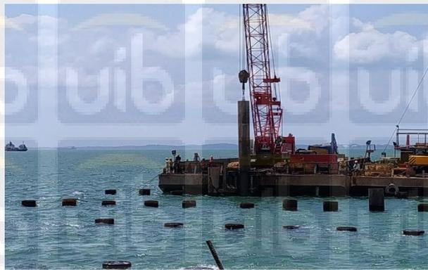
Gambar 4.8 Proses Pemancangan, Sumber: Proyek Pembangunan Dermaga Kabil)
