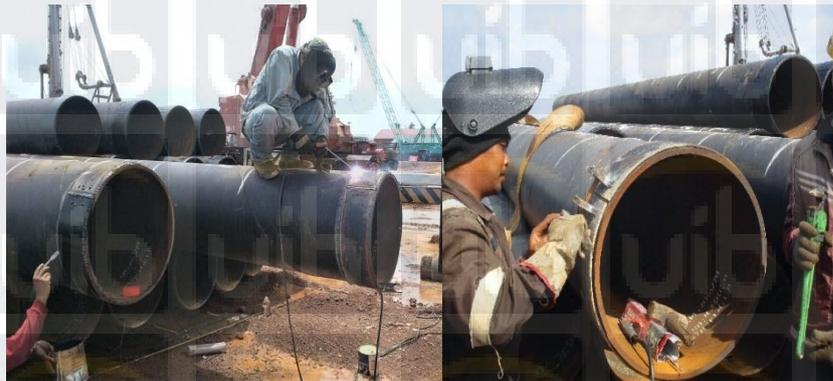
Gambar 4.7 Pengelasan *Shoe* Pipa Baja, Sumber: Proyek Pembangunan Dermaga Kabil
