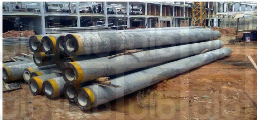
Gambar 2.9 Tiang Pancang Beton, Sumber: Proyek Pembangunan Dermaga Kabil
