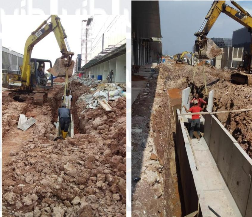
Gambar 4.5.4 Proses Pemasangan Baton Pracetak U-Ditch
