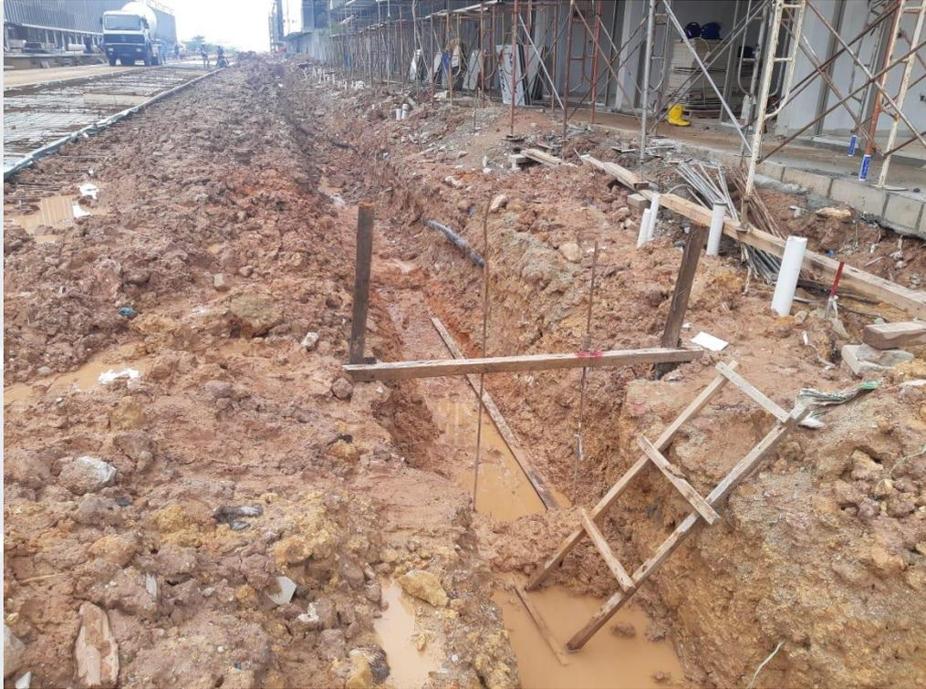
Gambar 4.5.1 *bouwplank* (papan bangunan)
