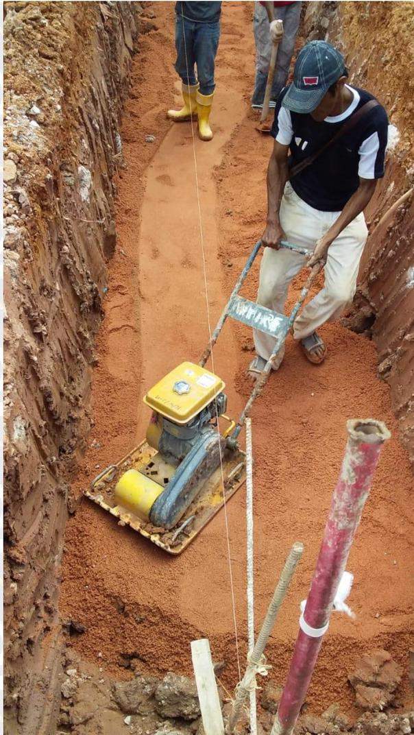
Gambar 4.5.3 Proses Pengurukan secara manual
