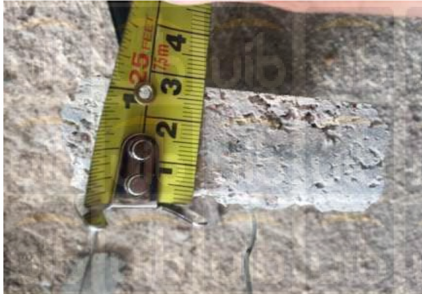
Gambar 4.4 : Beton Decking (tahu beton)
