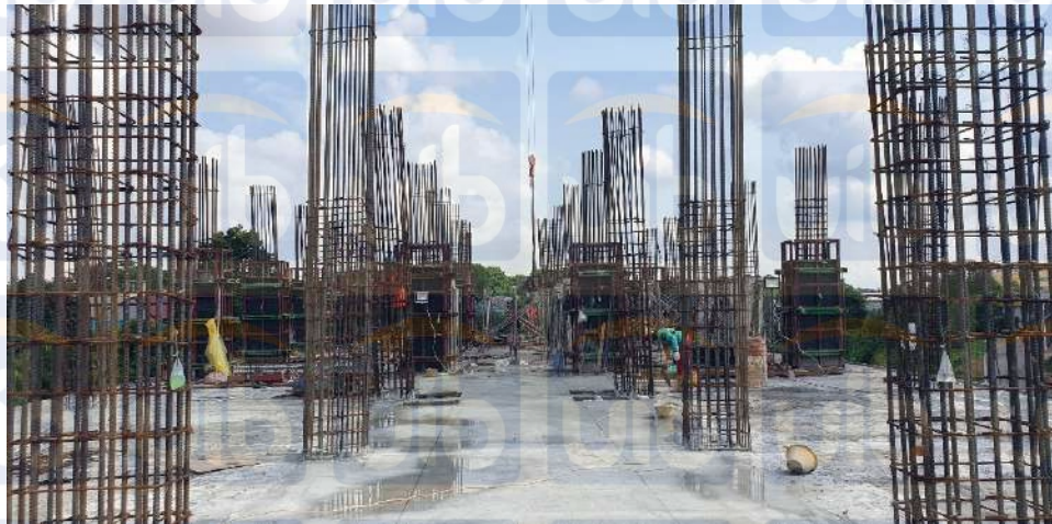
Gambar 4.4 Pekerjaan Kolom pada proyek Apartemen Puri Khayangan Residence Batam
