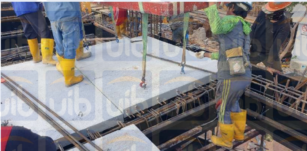
Gambar 4.6 Pemasangan Flyslab pada Proyek Apartemen Puri Khayangan Residence
