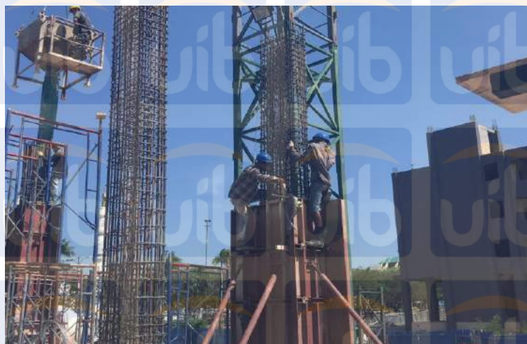
Gambar 4 pemasangan bekisting kolom
