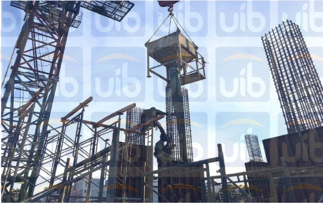
Gambar 5 pengecoran kolom
