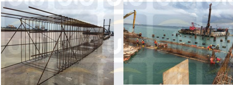
Gambar 4.13 : Tulangan Pile Cap dan Proses Pemasangan Tulangan
