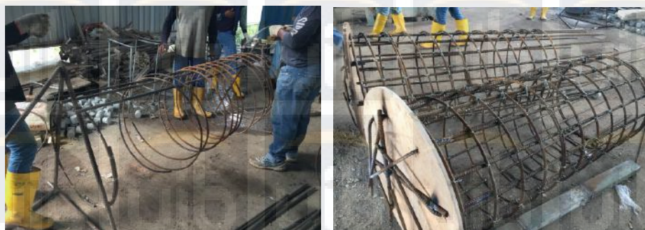
Gambar 4.9 : Proses Pembuatan Isian Tulangan Pipa Baja
