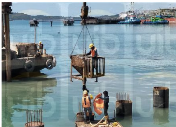
Gambar 4.11 : Pengecoran Tiang Pancang
