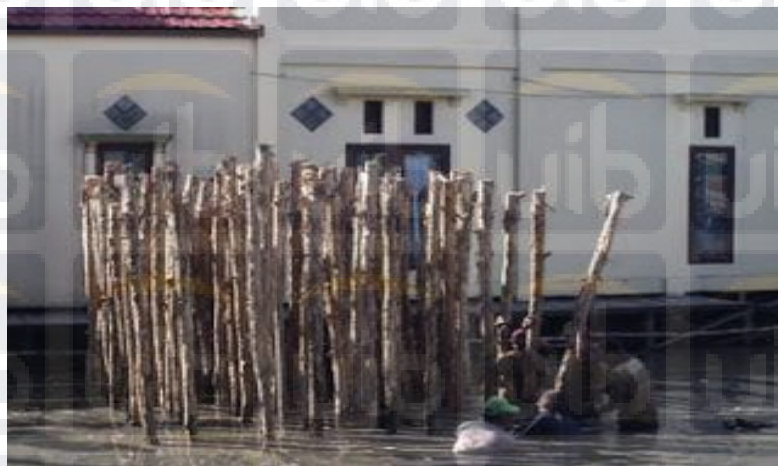
Gambar 2.7 : Tiang Pancang Kayu
