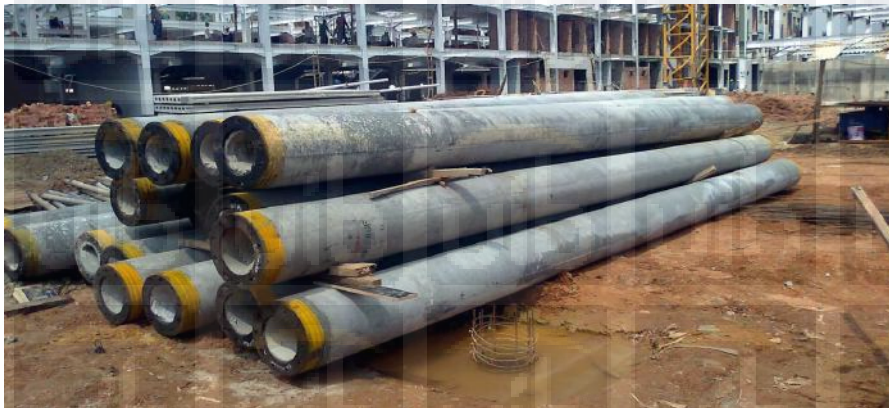
Gambar 2.6 : Tiang pancang Beton
