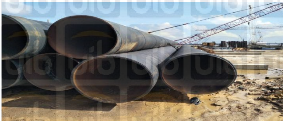
Gambar 2.8 : Tiang Pancang Baja
