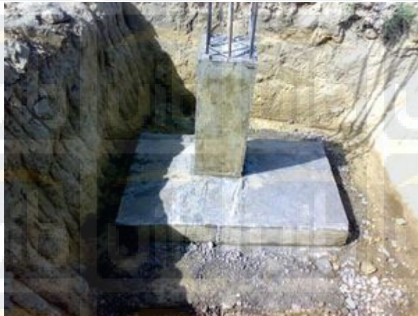
Gambar 2.1 : Pondasi Setempat/Tapak
