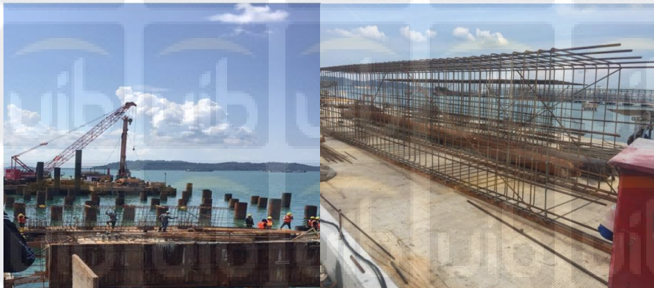
Gambar 4.10 Foto Tulangan dan Perakitan Pile Cap
