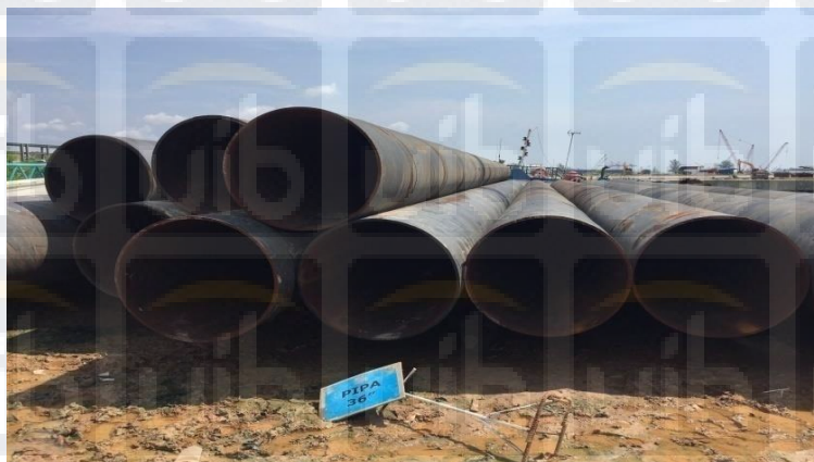
Gambar 4.5 Foto Tiang Pondasi/Pancang Pipa Baja
