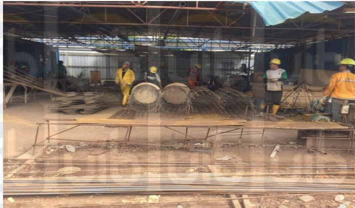
Gambar 4.6 Perakitan Tulangan Pondasi
