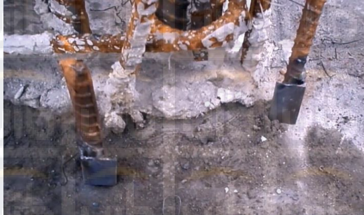
Gambar 4.3 Proses Pemasangan Kicker pada Kolom
