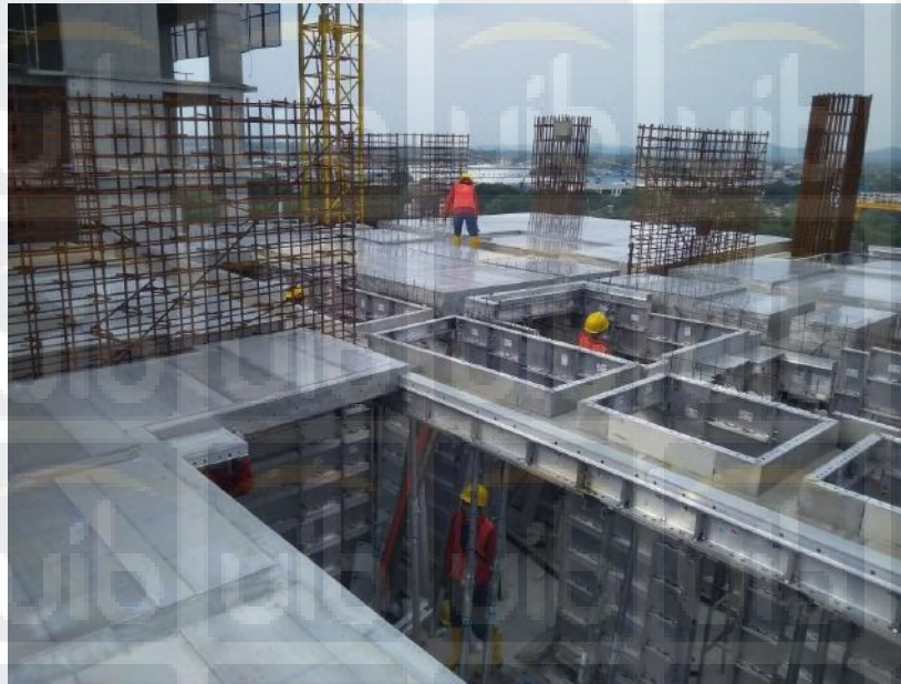
Gambar 4.8 Proses Pemasangan Panel Pelat Lantai
