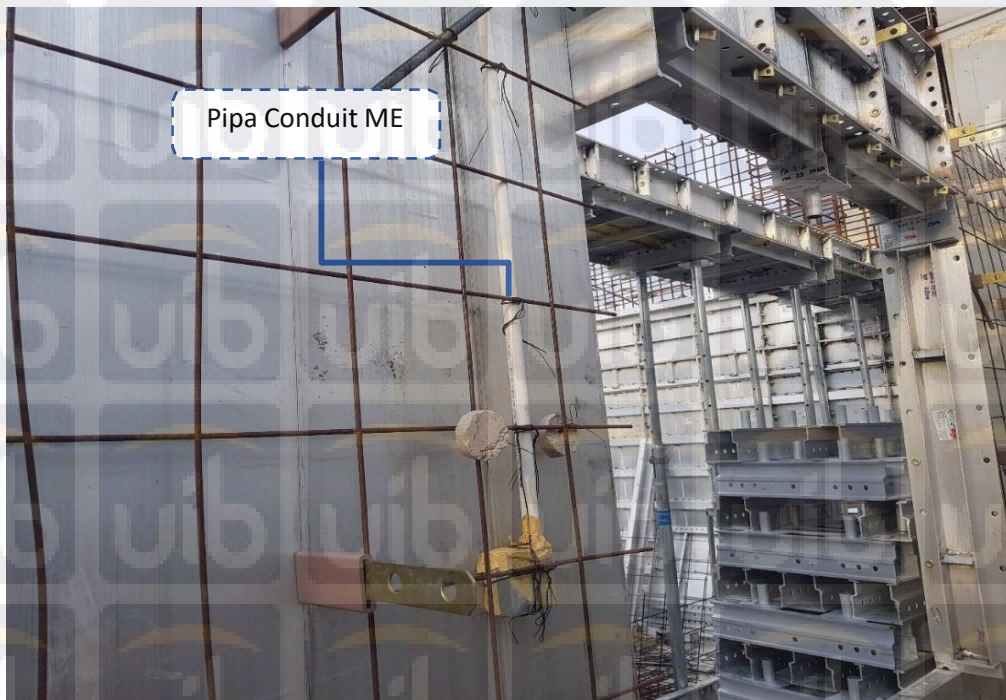
Gambar 4.5 Contoh Pemasangan Pipa Conduit ME
