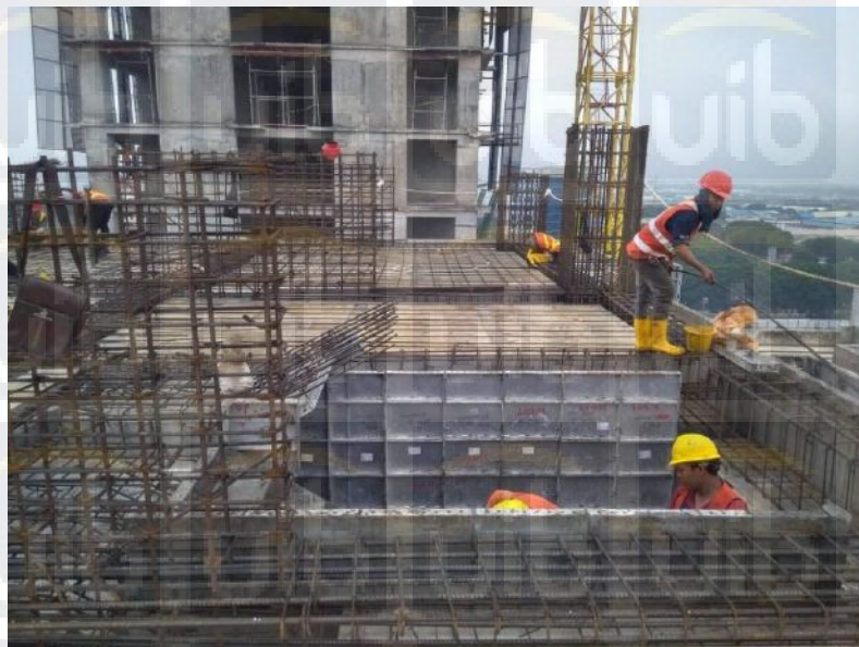
Gambar 4.9 Proses Pemasangan Tulangan Pelat Lantai
