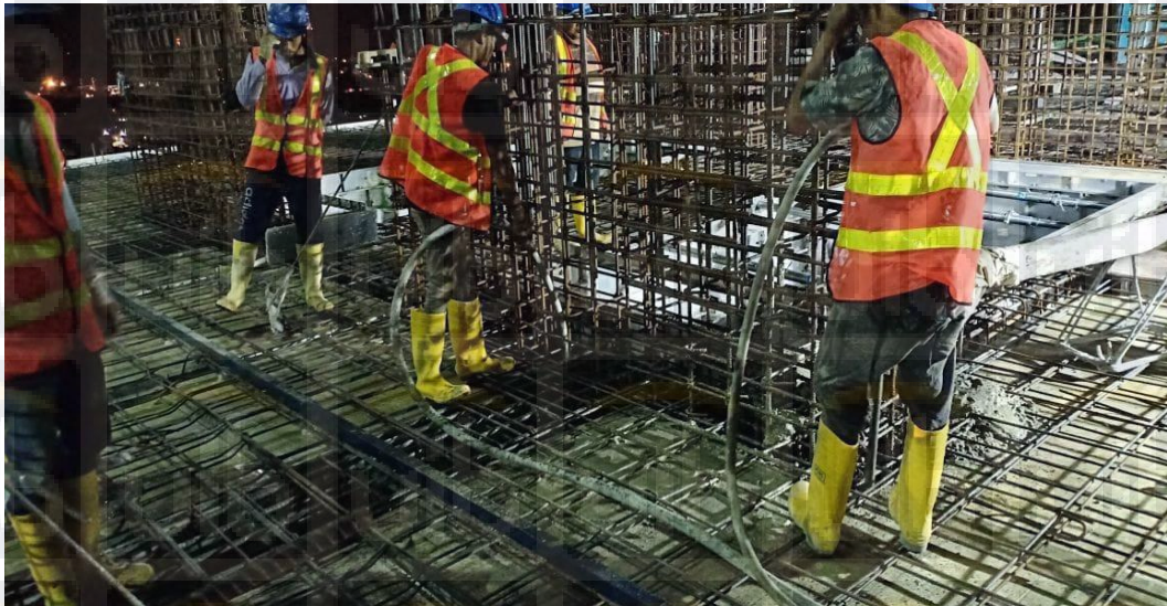
Gambar 4.10 Proses Pengecoran Vertikal
