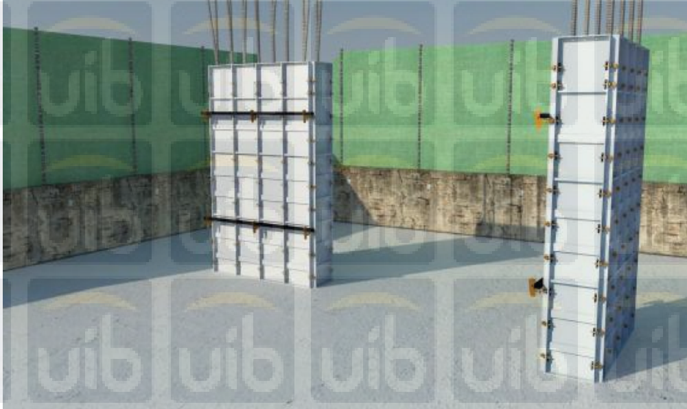
Gambar 2.2 Contoh Pemasangan Bekisting Kolom
