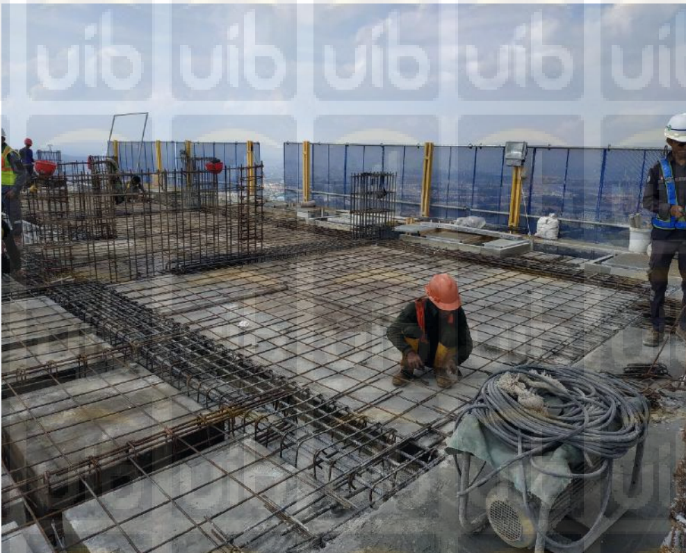
Gambar 2.4 Contoh Pemasangan Bekisting Balok & Pelat
