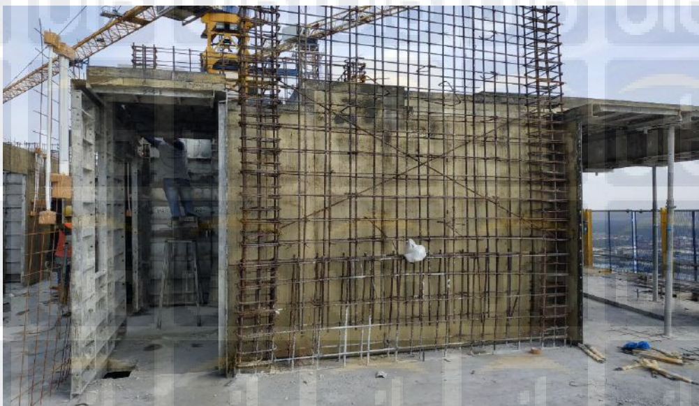
Gambar 2.3 Contoh Pemasangan Bekisting Dinding Geser
