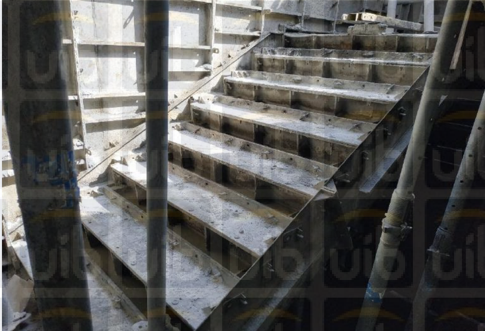
Gambar 2.6 Contoh Pemasangan Bekisting Tangga
