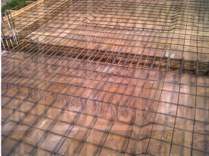
Gambar 6 Pekerjaan Pelat Lantai
