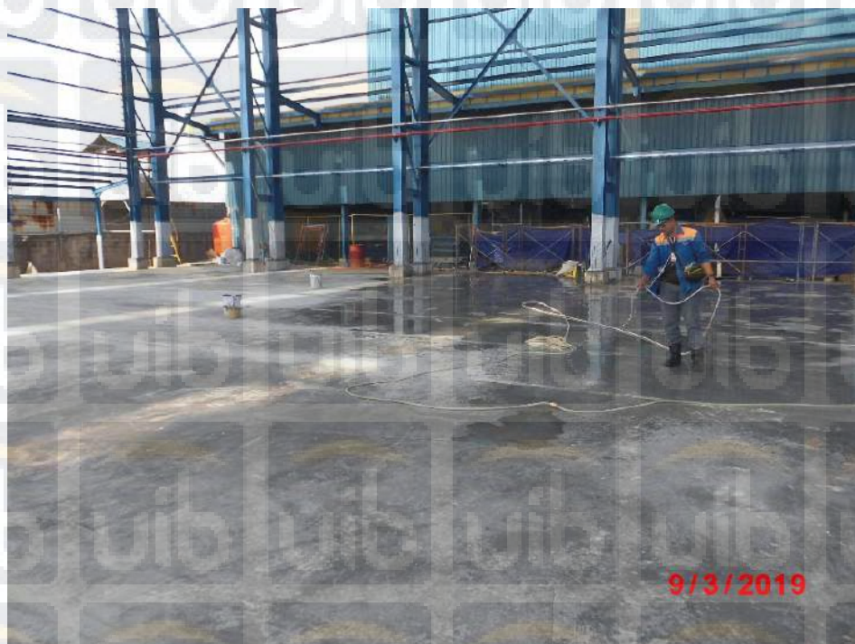
Gambar 4.6 Pengecoran slab
