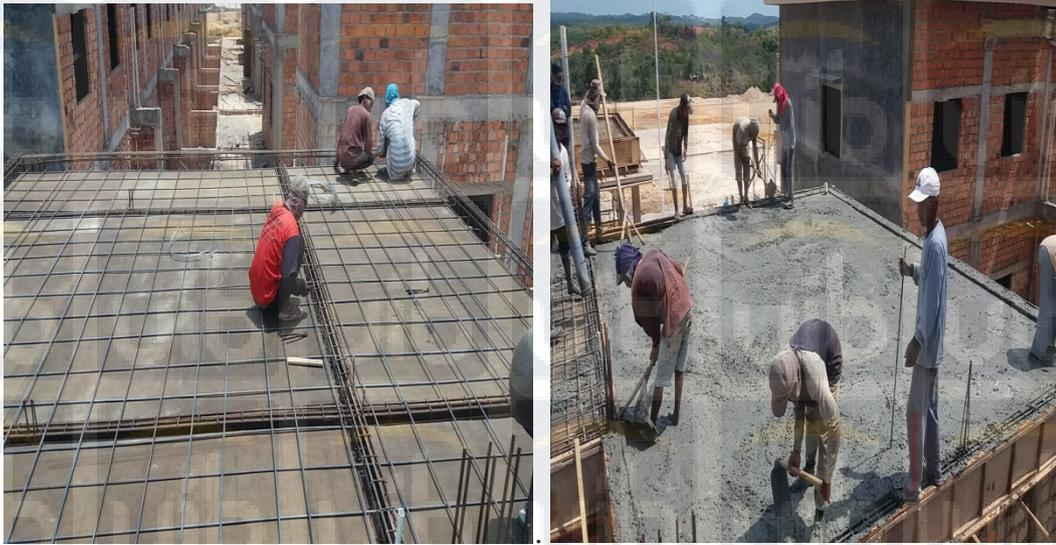
**Gambar 4.2 Pekerjaan Balok dan Pelat Lantai 2**
