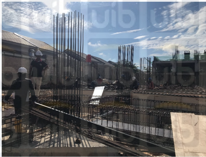
Gambar 4.2 Pekerjaan pembesian groundbeam
