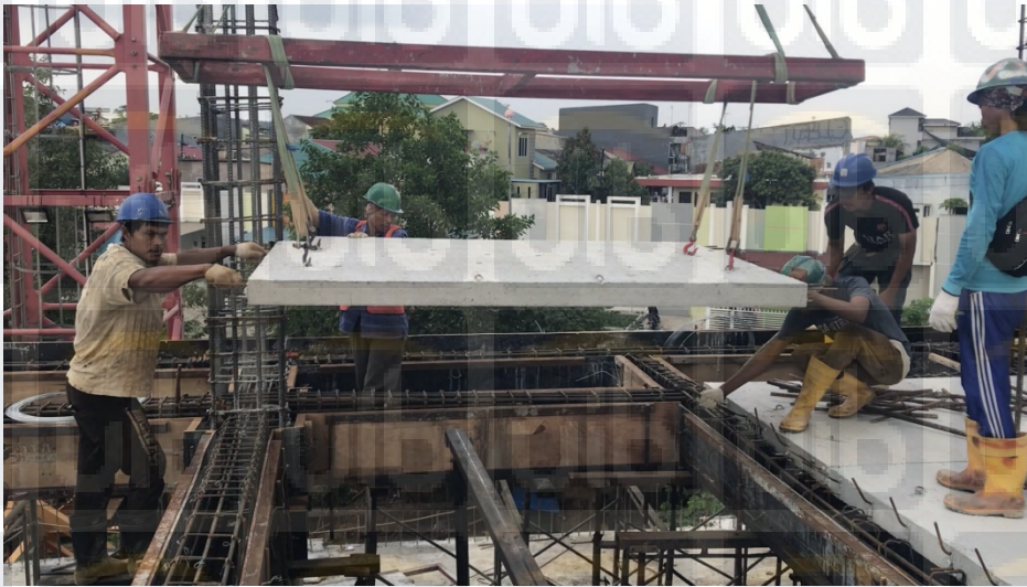
Gambar 4.3 Pekerjaan Pemasangan Pre-cast Flyslab
