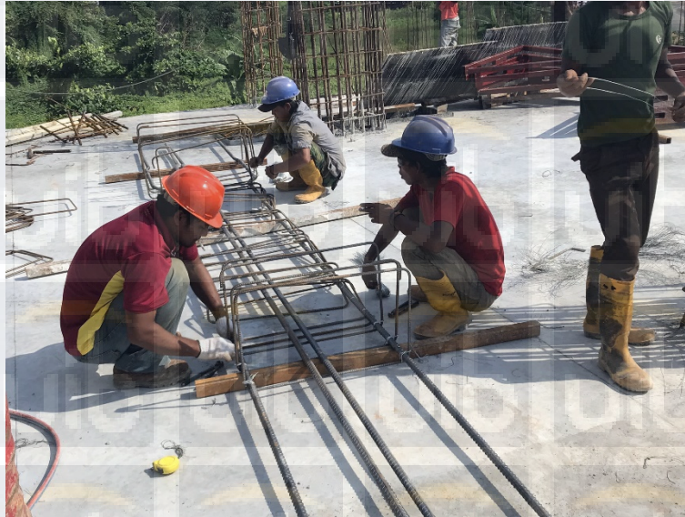
Gambar 4.4 Pekerjaan pembedian Kolom
