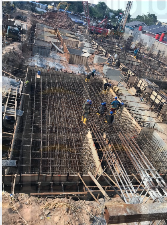
Gambar 4.1 Pekerjaan pembesian pile cap
