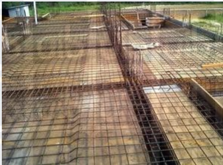
Gambar 4.1 Pekerjaan plat lantai
