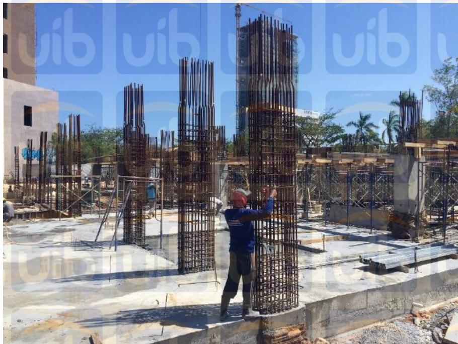
**Gambar 4.1.** Pekerjaan Pembesian Kolom
