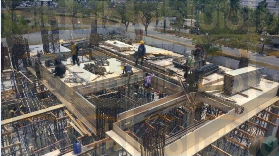
**Gambar 4.5.** Pekerjaan Pembesian Balok
