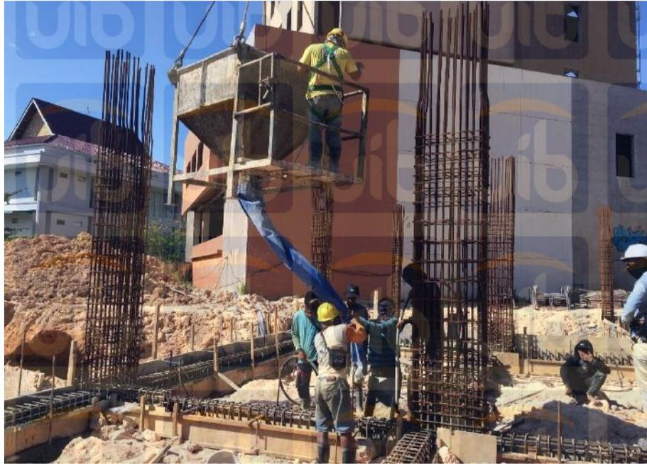
**Gambar 4.6.** Pekerjaan Pengecoran Balo
