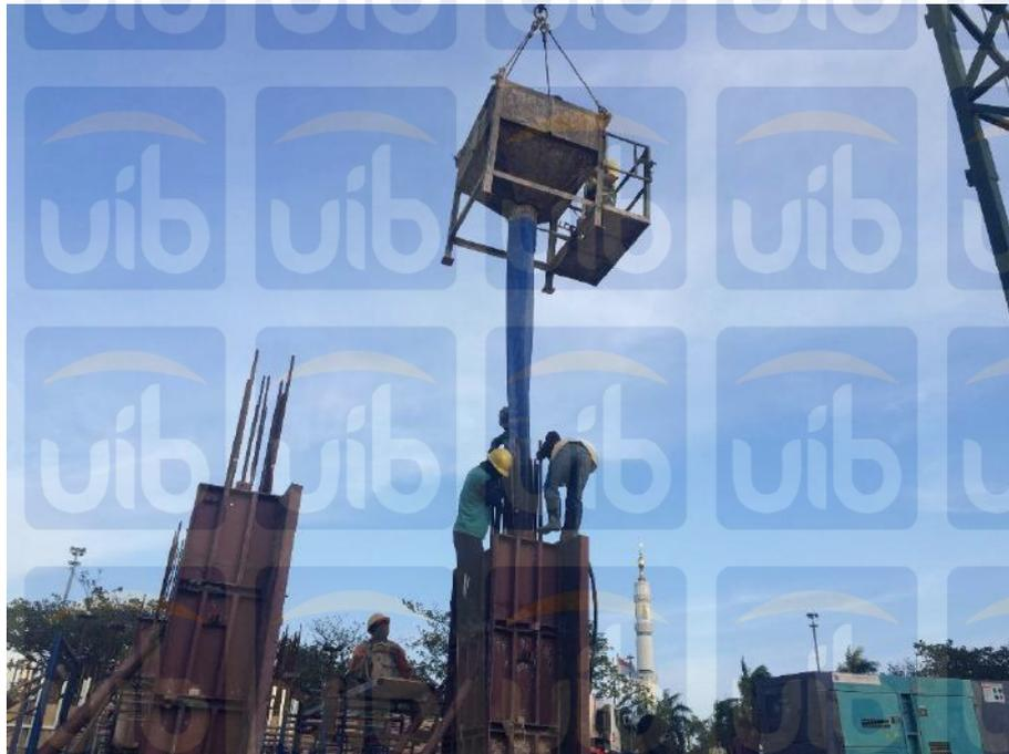
**Gambar 4.3.** Pekerjaan Pengecoran Kolom
