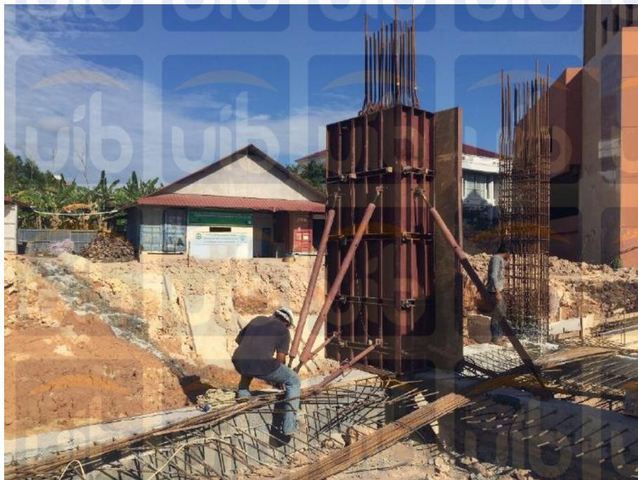
**Gambar 4.2.** Pekerjaan Pemasangan Bekisting Baja Kolom
