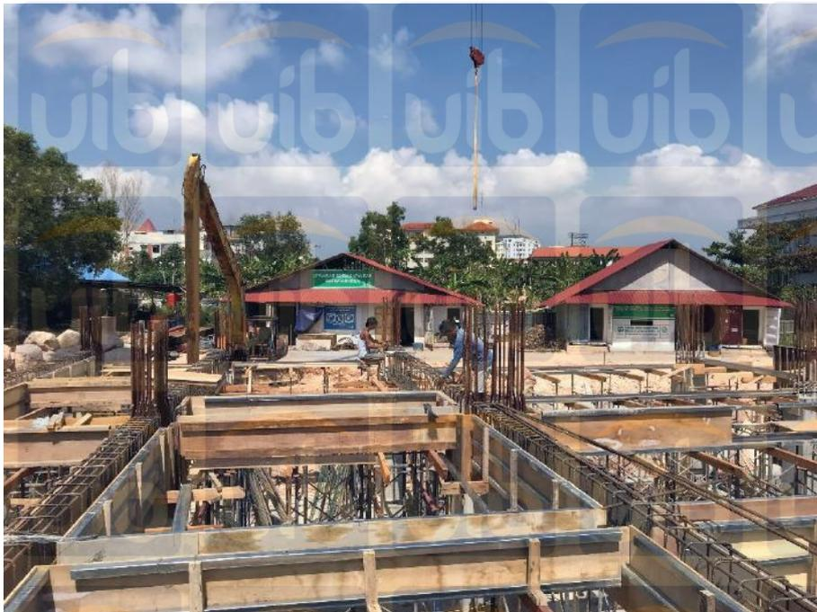
**Gambar 4.4.** Pekerjaan Pemasangan Bekisting Kayu Balok
