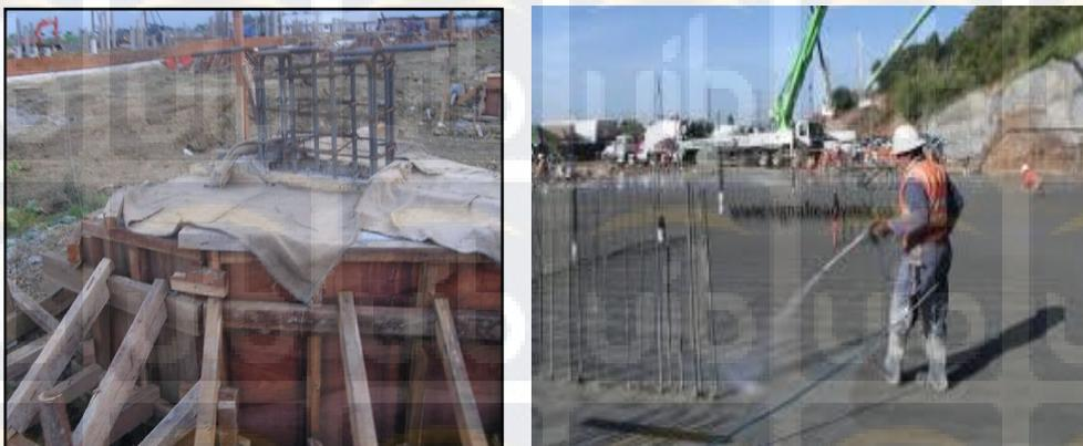
Gambar 4.6 Perawatan Beton (*curing*)
