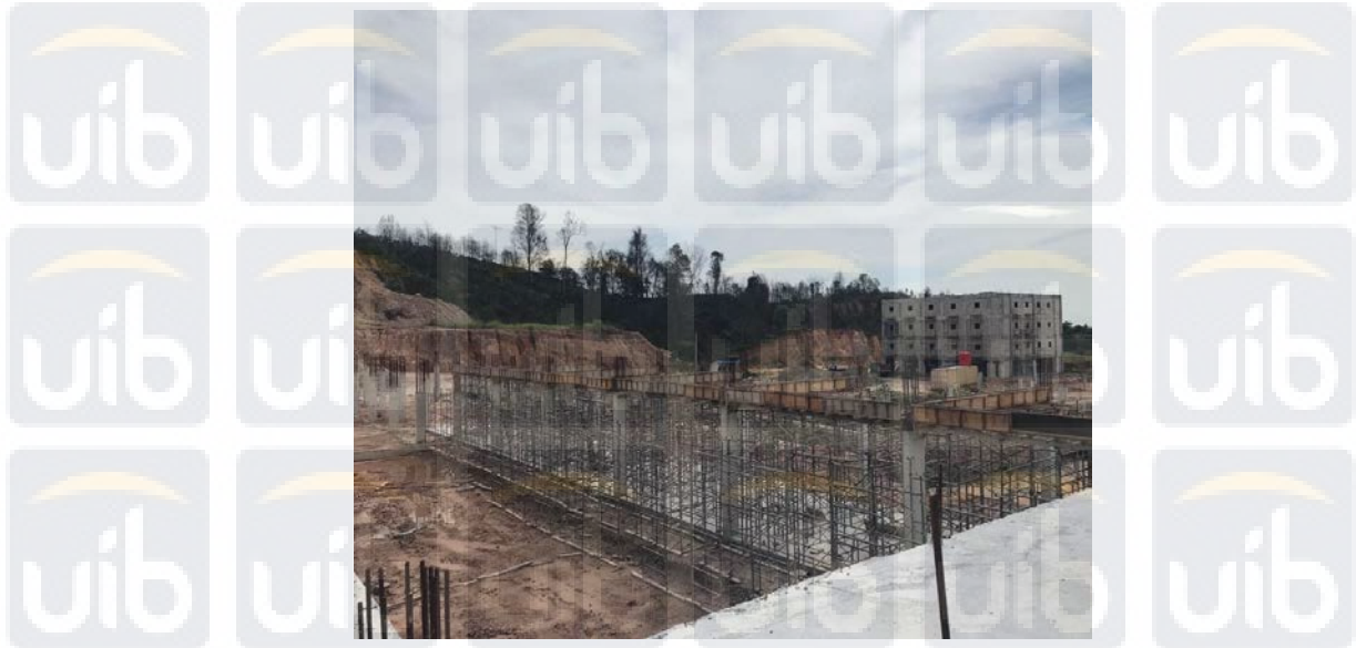
Gambar 4.9 Struktur Balok dan Pelat Lantai
