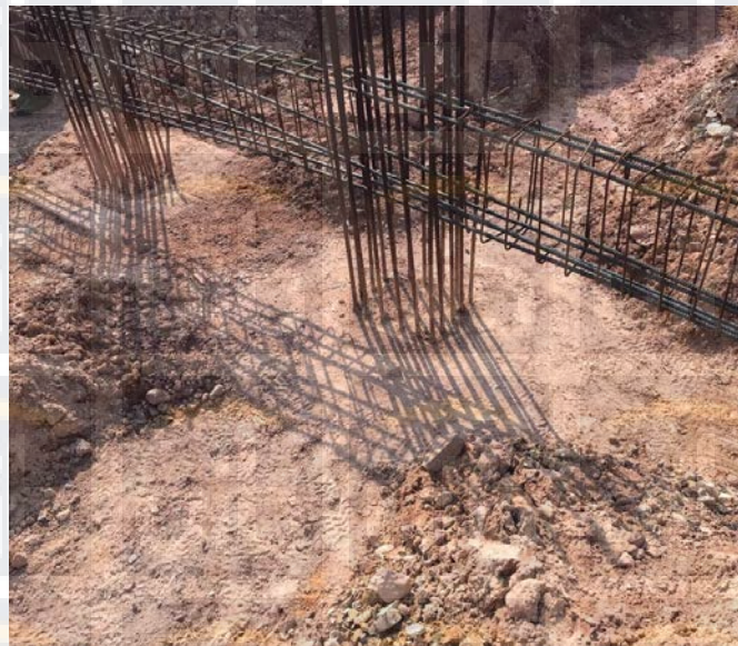
Gambar 4.7 Struktur Sloof
