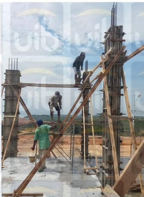
Gambar 4.1 Pengecoran Kolom Lantai 2
