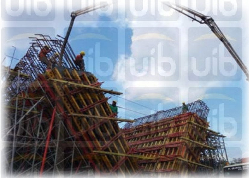
Gambar 4.8 Pengecoran Pier
