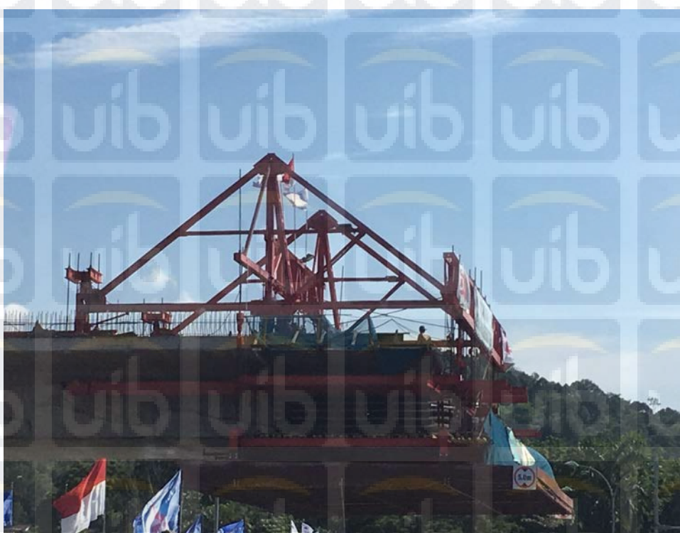
Gambar 2.2 Pemasangan Traveler di Pierhead zona 6,
