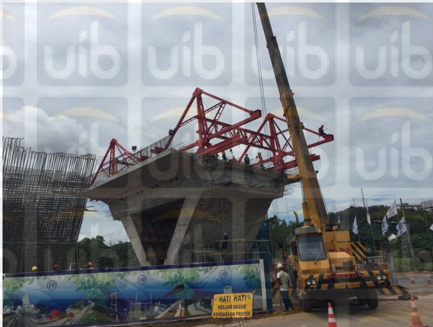
Gambar 2.2 Pemasangan Traveler di Pierhead zona 6,
