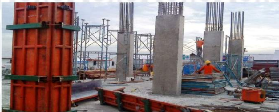
Gambar 4.1 Kolom yang telah berdiri
