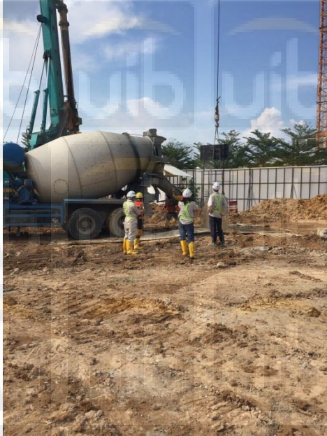
Gambar 2.14 Beton readymix , sumber : gambar lapangan
