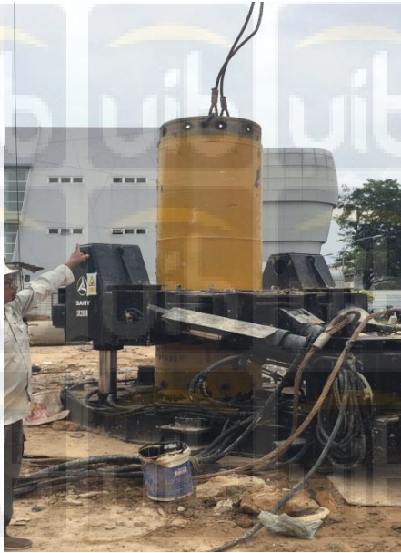
Gambar 2.9 Galian tanah bored pile , sumber : gambar lapangan
