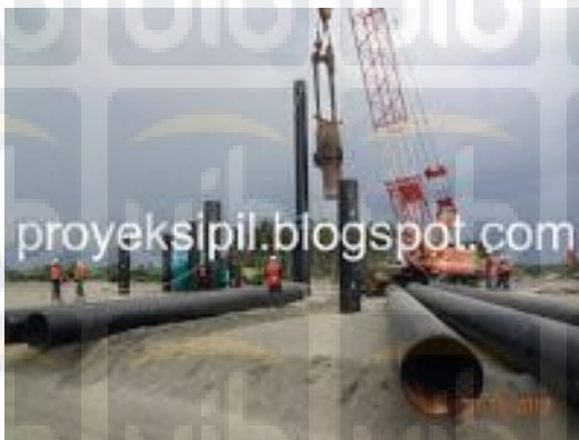
Gambar 2.4 Pondasi tiang pancang baja , sumber :
