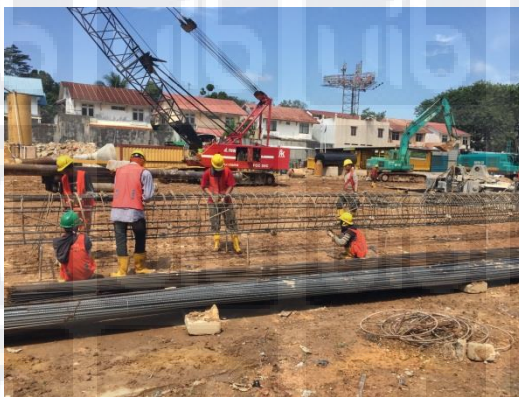
Gambar 2.10 Pekerjaan pembesian, sumber : gambar lapangan
