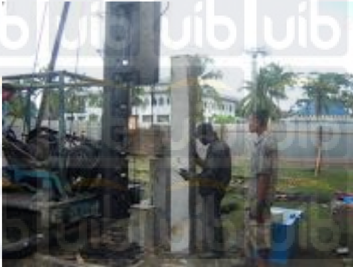
Gambar 2.3 Pondasi tiang pancang beton , sumber :
