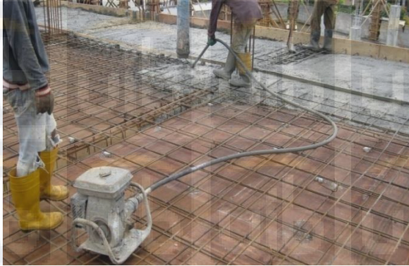
Gambar 2.24 Concrete vibrator, sumber : gambar lapangan
