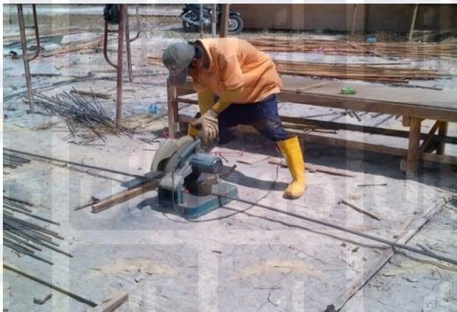
Gambar 2.19 Bar cutter, sumber : www.ilmusipil.com › alat berat
