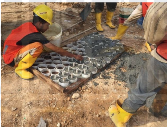
Gambar 2.18 Beton decking , sumber : gambar lapangan
