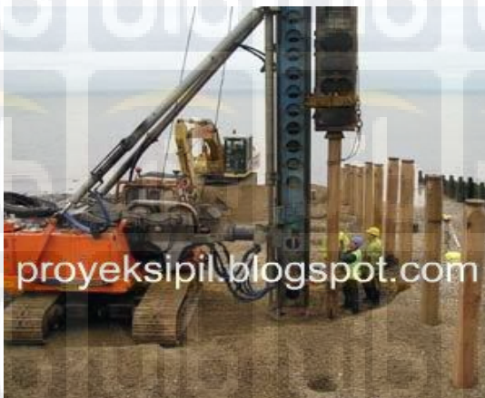
Gambar 2.2 Pondasi tiang pancang kayu , sumber :
