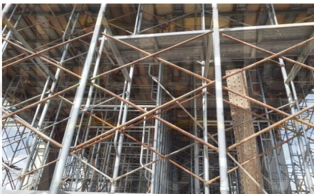
Gambar 2.22 Scaffolding , sumber : gambar lapangan
