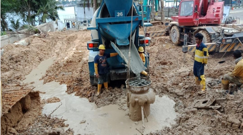
Gambar 4.8 Pengecoran
