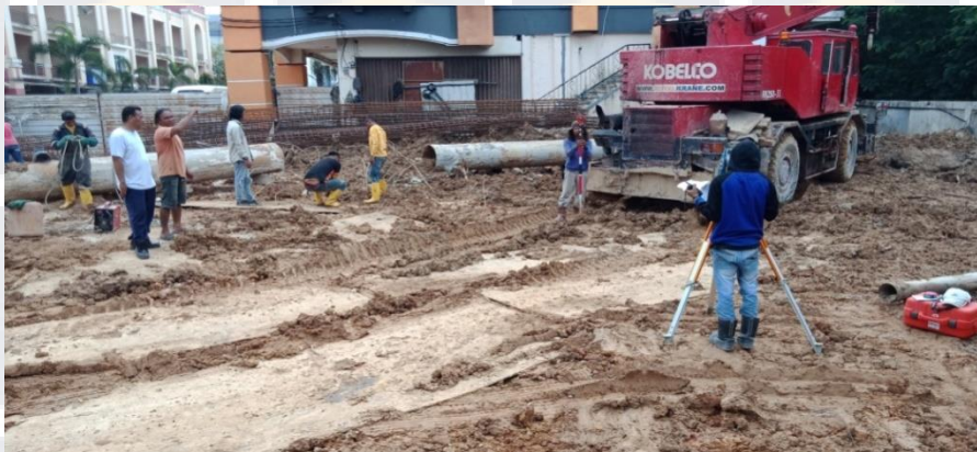
Gambar 4.2 Pengukuran lahan Sumber gambar : Proyek
