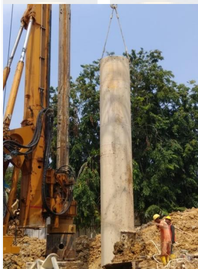
Gambar 4.4 Pemasangan cassing temporary
