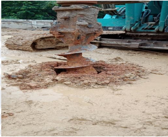
Gambar 4.3 pengeboran menggunakan auger
